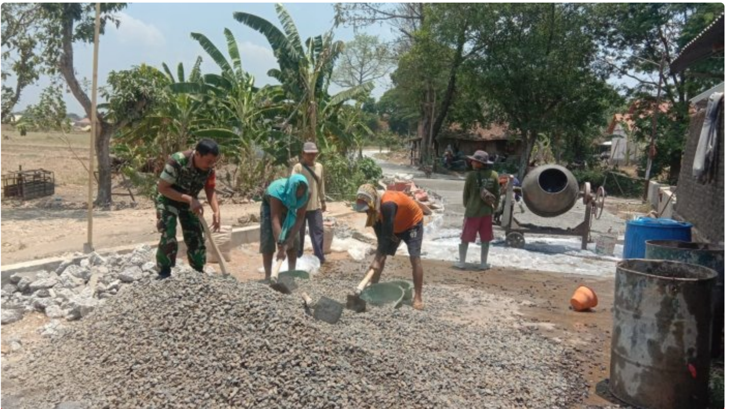
(Foto Istimewa) Sertu Rozak saat bergotong royong pengecoran jalan bersama warga
