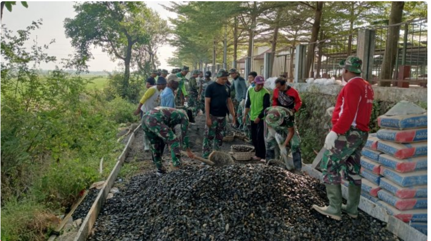
Foto istimewa ( Satgas tmmd reg 116 kebut pengecoran jalan
